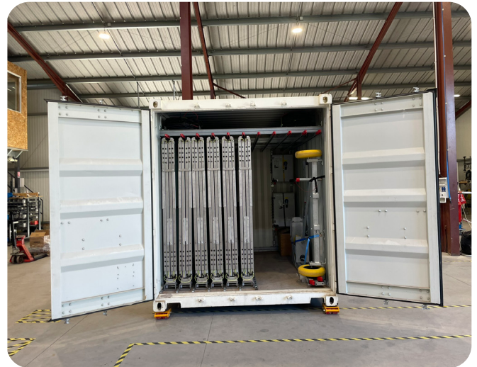
Système de racking - stockage des Solar-Wings®
