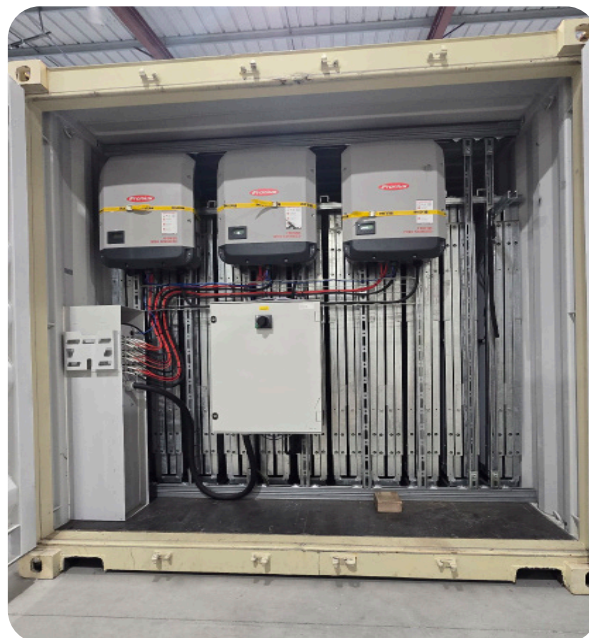
Container On-Grid mit Umwandlungseinheit
